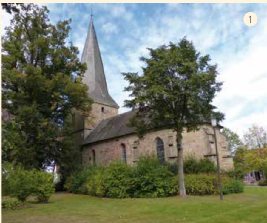
Das Mauerwerk der denkmalgeschützten Kirche weist zahlreiche Spuren einer ereignisreichen Baugeschichte auf, die noch nicht abschließend geklärt ist. Rötlich verfärbte Sandsteine im unteren Teil des romanischen Turmes lassen eine partielle Zerstörung durch Brand vermuten. Der obere Teil zeigt Schalllöcher mit gekuppelten (Zwillings-) Fenstern und gotischen Dreipässen, der Turmhelm ist spätgotisch. ① ②
